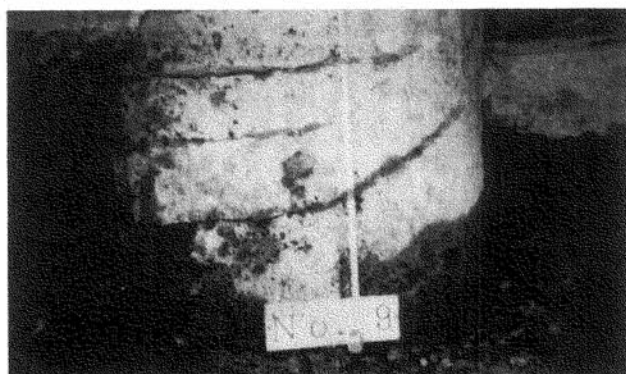
群杭試験後杭頭部クラック状況
