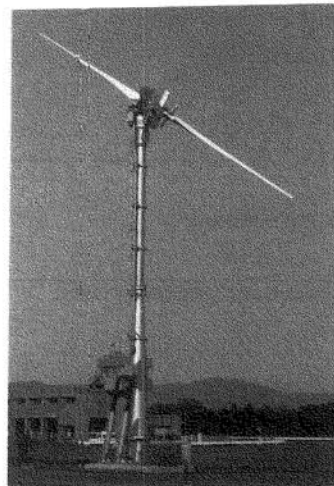
風車タワー全景
